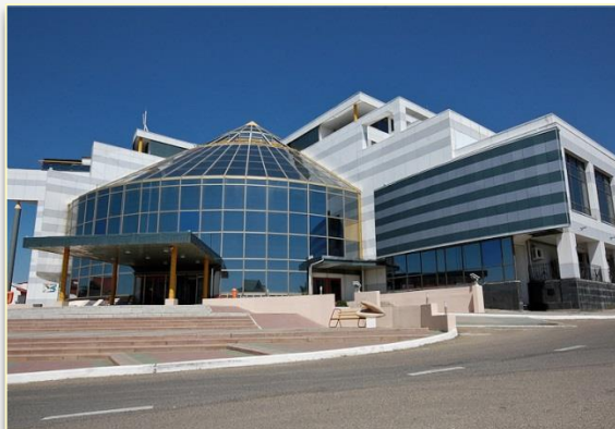
Строительство Сити Чесс
